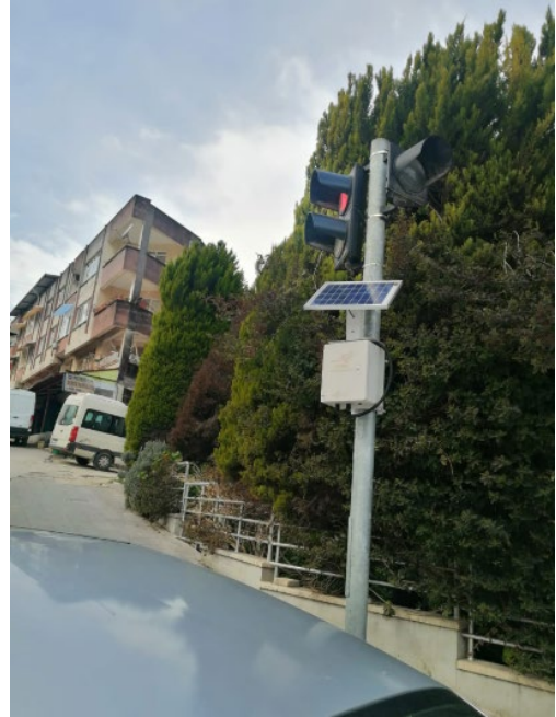
Şekil 4. Tasarlanan Modülün Pilot Kavşağa Uygulanması
